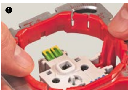
Funktionseinsatz in Befestigungsplatte einschnappen
