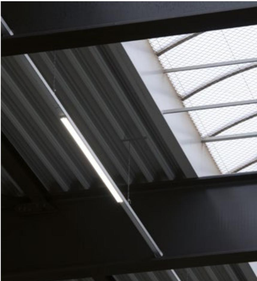
Wenn ausreichend Tageslicht durch die Oberlichter in die Produktionshalle fällt, regelt die DALI-Steuerung die LED-Beleuchtung automatisch herunter.
