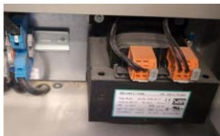
Les chargeurs à thyristors sont généralement montés dans l'armoire de l'installation et sont reconnaissables à leur forme typique de transformateur.
